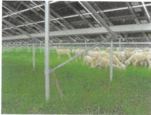
Exemple d' éco pâturage – centrale solaire de Toul (EDF Renouvelables)
